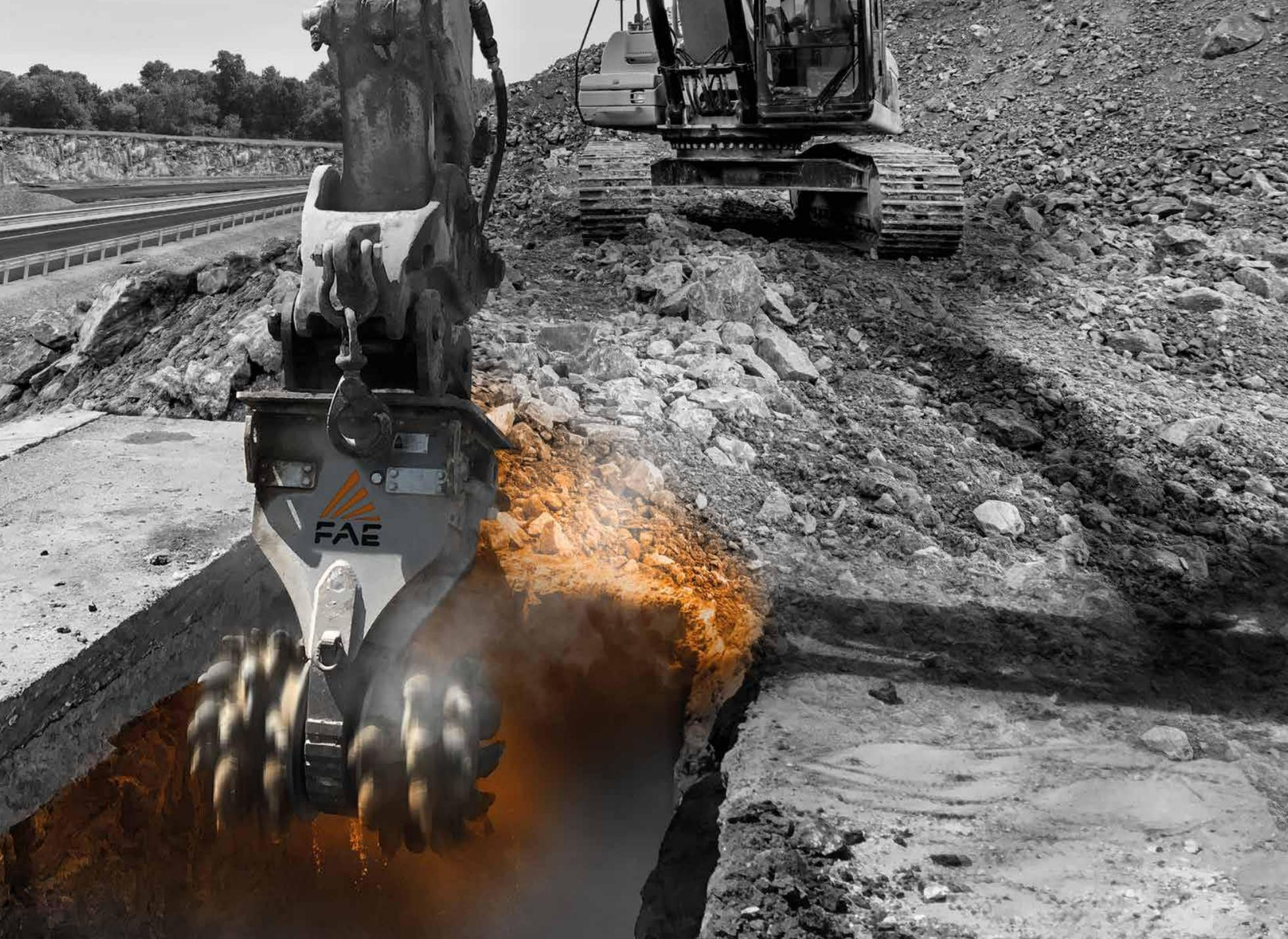
BROYEURS À TRANSMISSION HYDRAULIQUE
